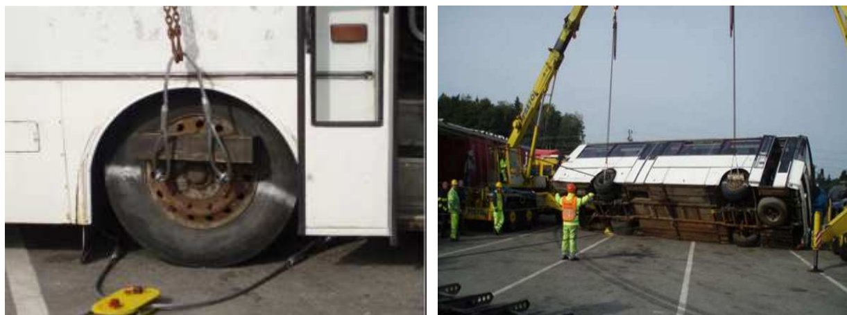
Obrázek 65: Vypodložení vázacích lan vhodným trátkem, který zamezí poškození boku trolejbusu při jeho zvedání –lit. [32]
