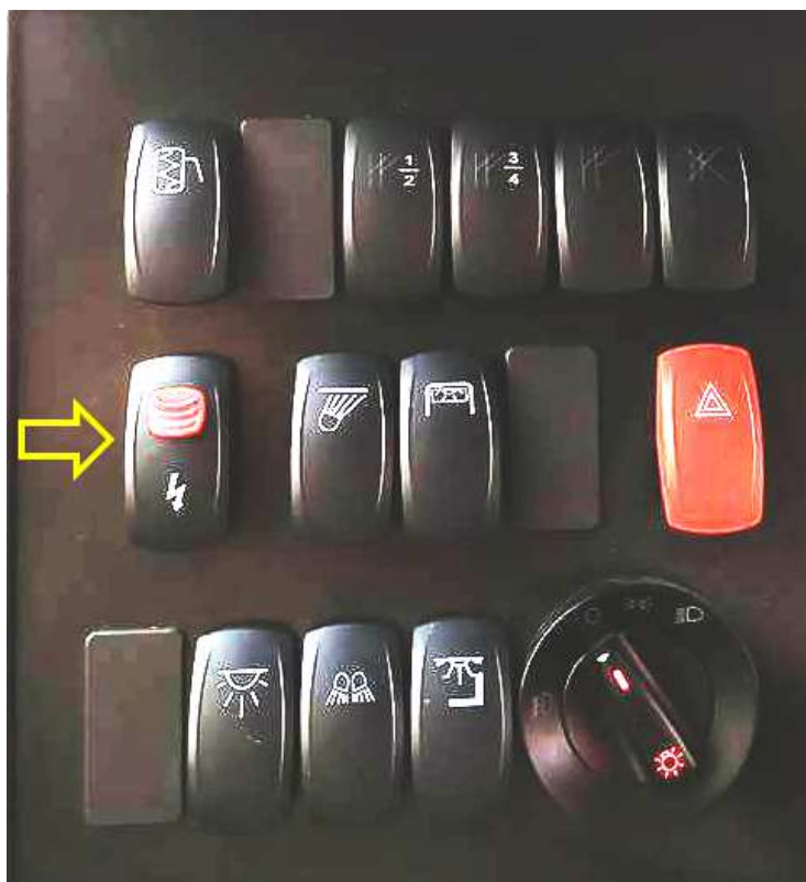
Obrázek 75: Spínač nouzového odpojení trolejbusů 26Tr a 27Tr (vlevo uprostřed) v karosérii Solaris New Urbino – lit. [41]
